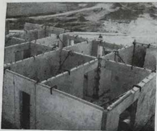
Рис. 75. Общий вид крупнопанельного дома для сейсмических условий в процессе монтажа
