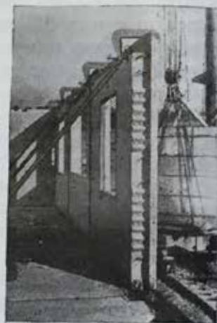
Рис. 76. Монтаж панелей наружных стен для строительства в сейсмических условиях
