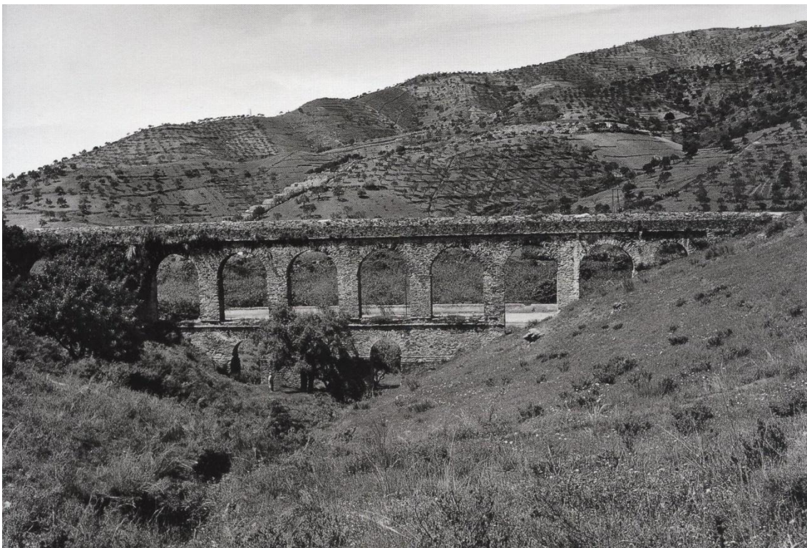
Fig. 3.94 – Almuñécar: Aqueduct (Hidalgo et al. 2008: fig. 289).
